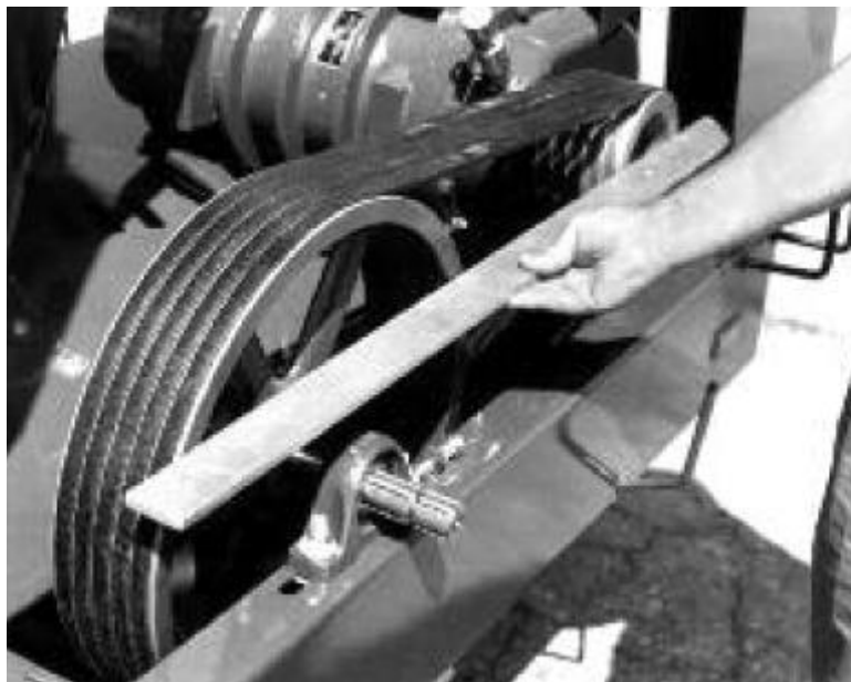
Рис. 8 Проверка правильности установки шкивов
